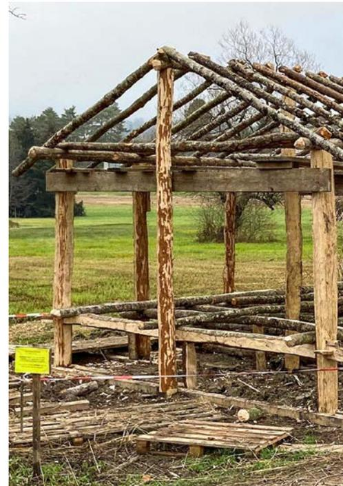
Das fertige Traggerüst mit Dachlatten. Nur bei ei-wurden sicherheitshalber moderne Holzschrauben
