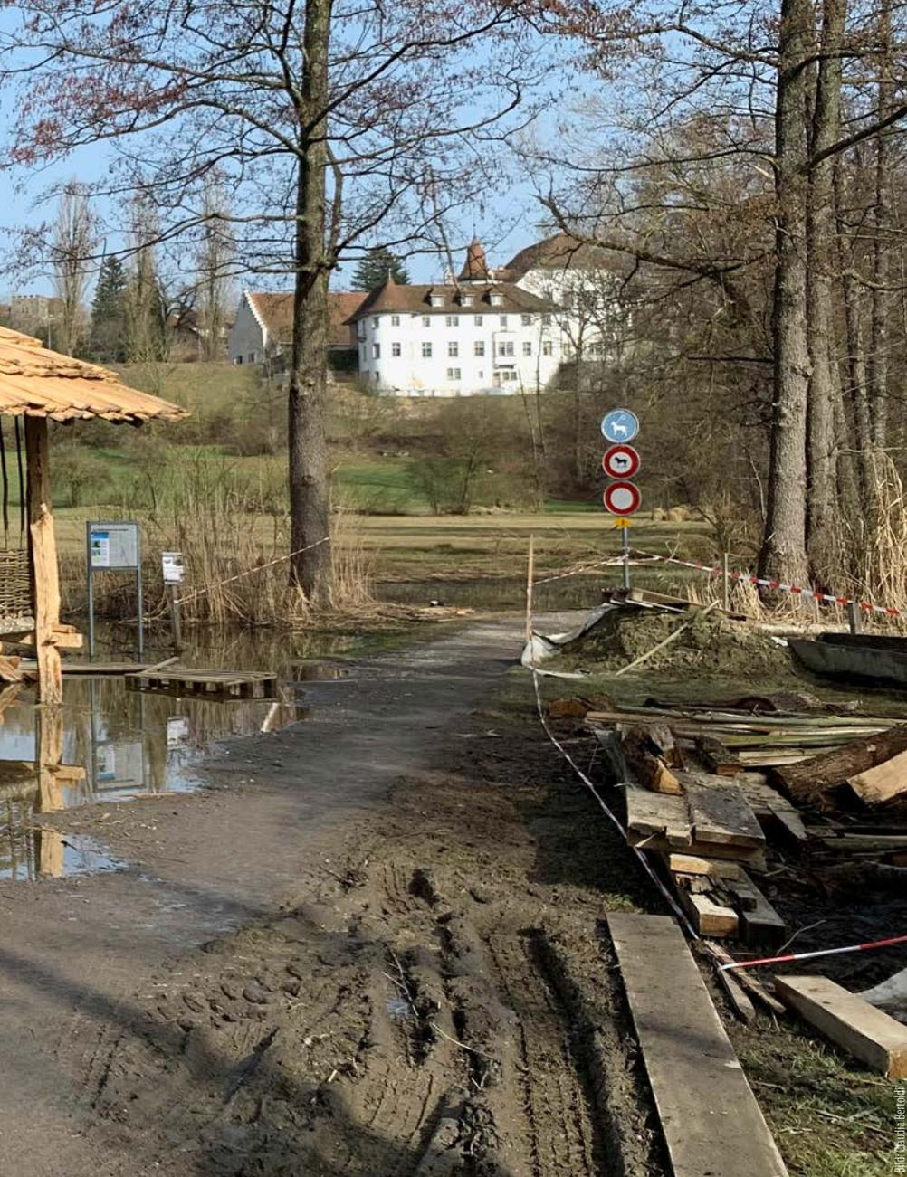
Baustelle leicht überschwemmt, aber bei einem Pfahlbau droht kein Wasserschaden im Keller. Gut zu sehen sind die geflochtenen Wände, die in Kürze mit Lehm verkleidet werden.
