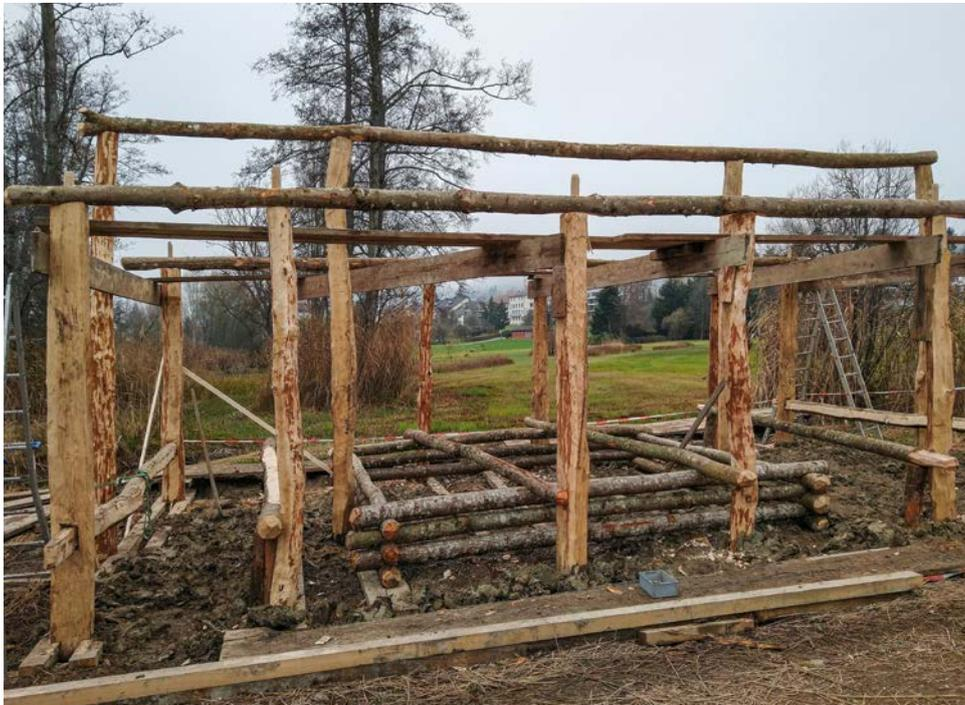
Das einfache Traggerüst des Gebäudes wurde mit Eichenstämmen und prähistorischer Technik ausgeführt. Nur die dafür verwendeten Werkzeuge sind modern, ansonsten würde der Bau zu lange dauern.
